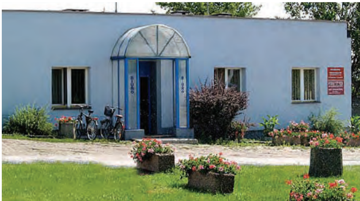
▲ Biurowiec PWK przed modernizacją.
